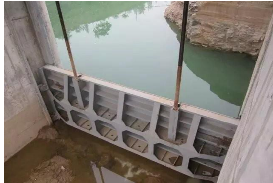
Fig. 3. Door groove embedding
